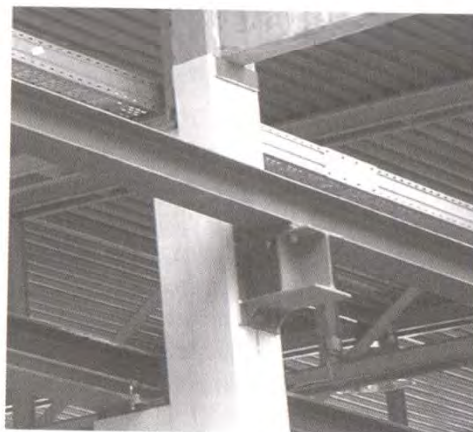
Abb. 7-9 Nicht grundsätzlich empfehlenswert: Zwischenaufleger ohne Quersteife
