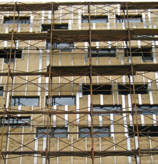
Gradnja prizidka G2 - FERI
